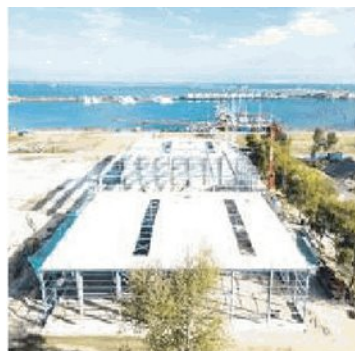
Bau einer Bootseinstellhalle in Norddeutschland. Foto: PEM Buildings
