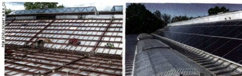
Das Dach der Sporthalle Lorach vorher (li.) und die nachhaltige Lösung nach Projektende (re.)
