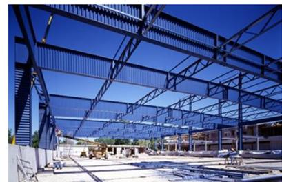
**SIN-Beam** (Wellstegträger) wird in allen möglichen Kombinationen und Bauwerken eingesetzt, vor allem aber im Hallenbau
